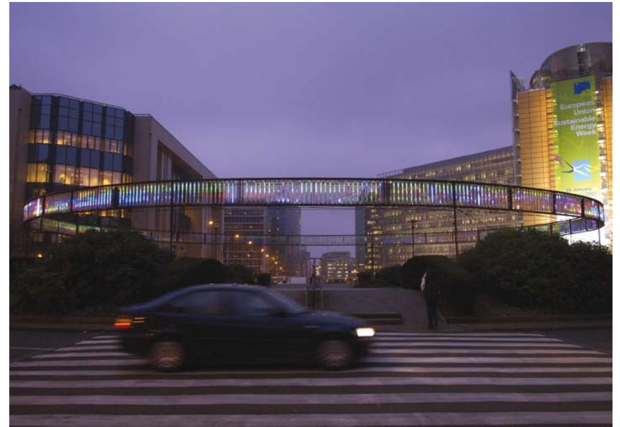
Untersicht der abspannung des Ringträgers
